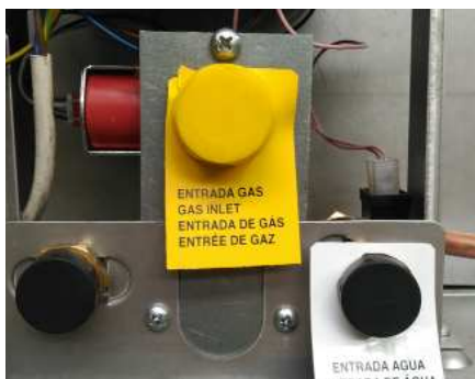
fig. 10 - Tarjetas de conexiones
